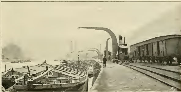
Abb. 221. Dampfkrane auf dem Umschlagplatz in Aussig a. d. Elbe.
